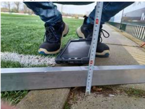
Verzakking (32mm) tegel bij sproeideksel
