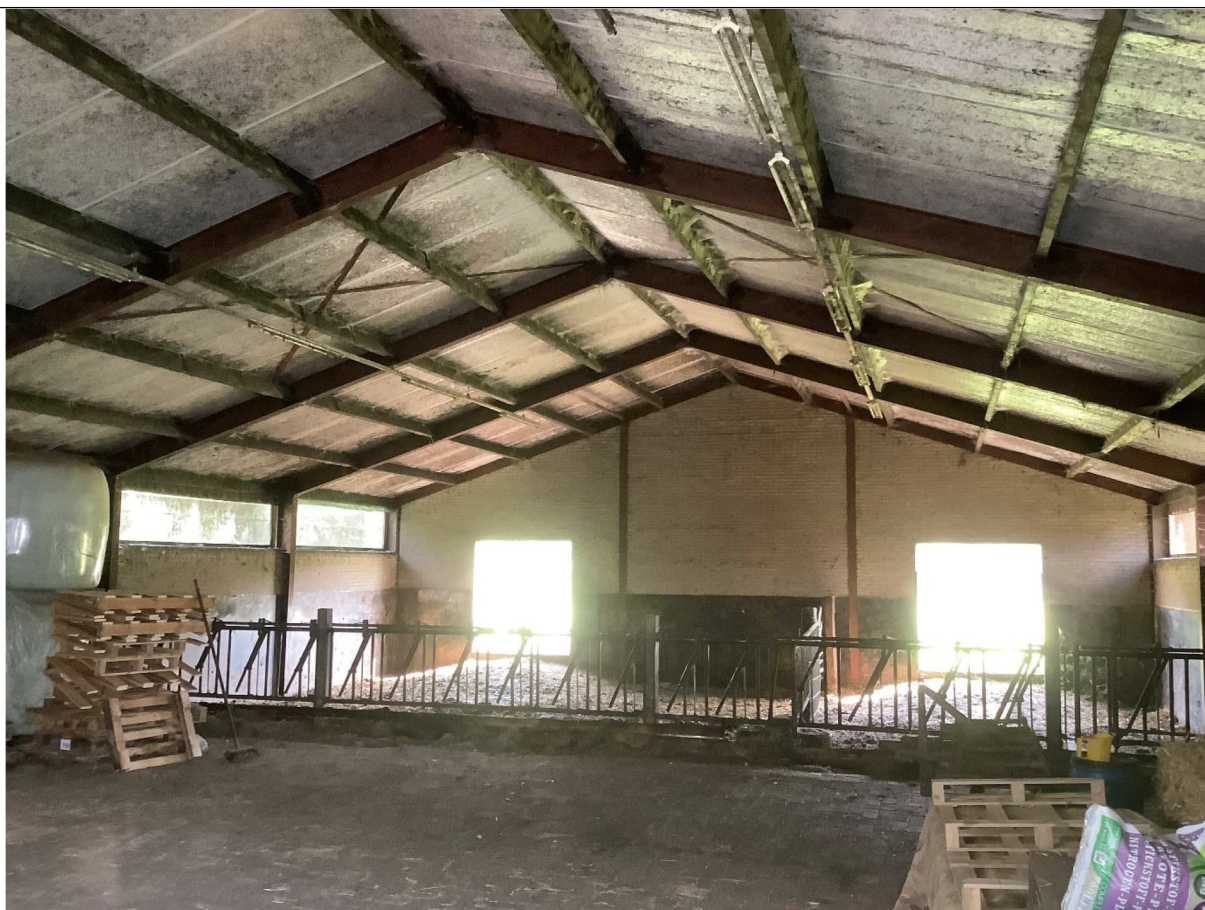
Foto 5: binnenzijde bestaande schuur
