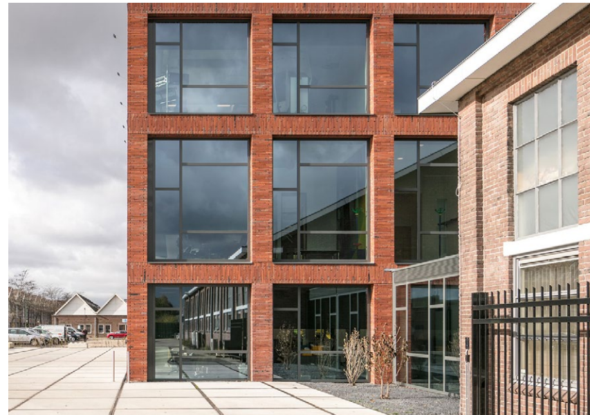
Figuur 10: Zichtbare gebouwconstructie in combinatie met grote glaspartijen in ranke kozijnen in combinatie met staal
