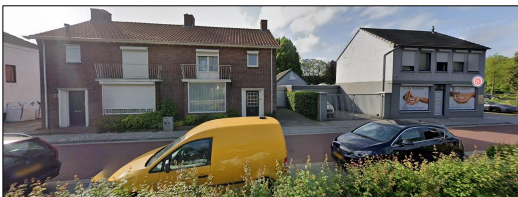
Figuur 4: Het plangebied gezien vanaf de Mierloseweg
