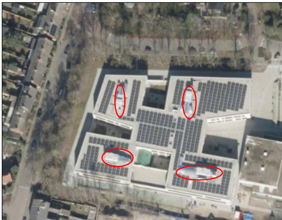
Figuur 4 rood is de locatie van de luchtbehandelingssystemen.
